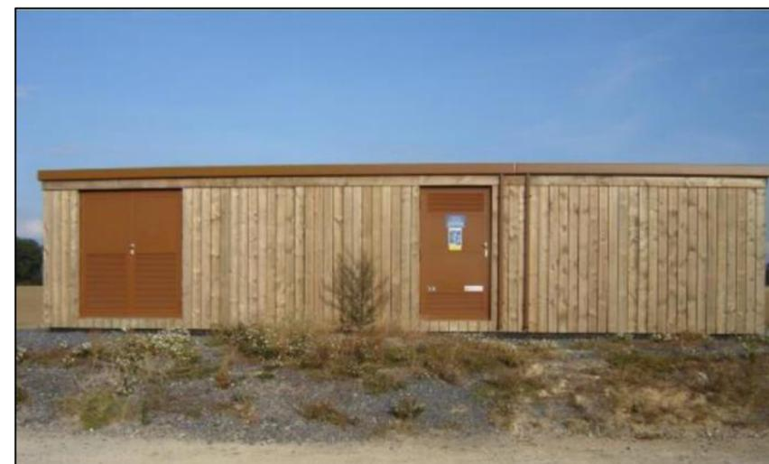
Figure 15 : Exemple d'un poste de livraison en bardage bois
