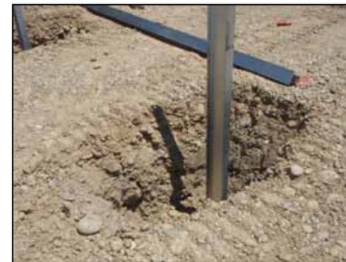
Dans certains types de sol, il est possible d'utiliser des pieux enfoncés dans le sol par le biais d'un enfonce-pieux, sans avoir besoin de fondations béton. Les pieux ou poteaux servant de support sont enfoncés dans le sol sur plusieurs dizaines de centimètres puis recouverts de béton ou non.
