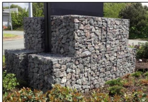
Les gabions sont généralement constitués d'un tissage de fils métalliques et remplis de pierres non gélives. Le plus souvent utilisés dans les travaux publics et le bâtiment pour construire des murs de soutènement, des berges artificielles non étanches ou décorer des façades, l'intérêt des gabions est avant tout une bonne tenue, une facilité de mise en œuvre et un caractère modulable.
