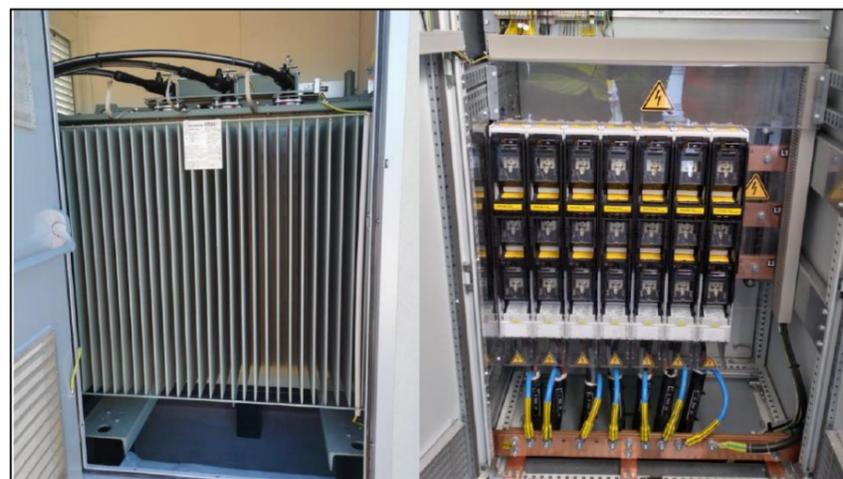
Figure 16 : Transformateur BT/HTA et TGBT 800 Vac à fusibles
