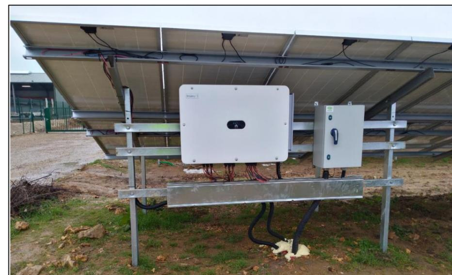
Figure 18 : Onduleurs photovoltaïques fixés à la structure porteuse des modules
