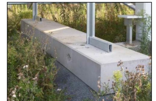
Figure 9 : Types de fondation - semelle béton
