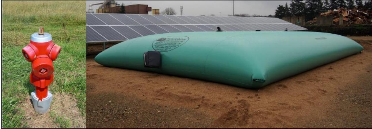
Figure 24 : Borne incendie (à gauche) et réserve incendie (à droite)
